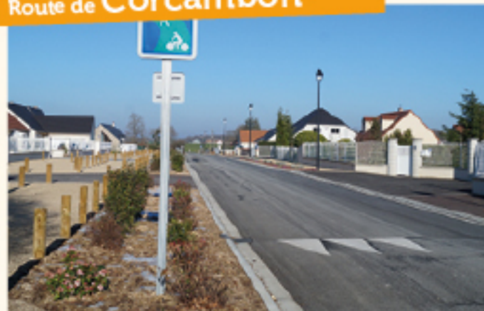
■ Réfection de la voirie.
