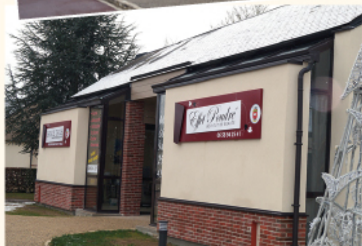
■ Isolation et embellissement des locaux.
